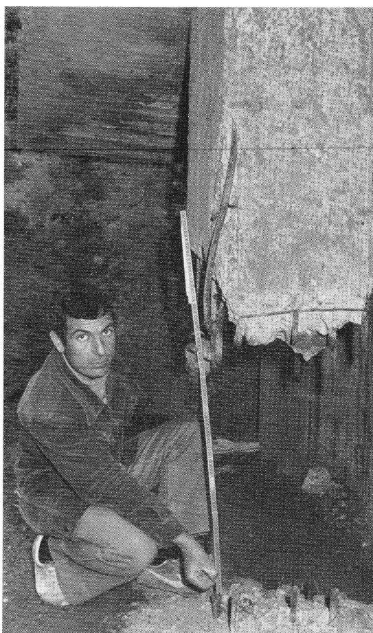
Foto 1 : distacco dei pilastri dopo sollevamento
