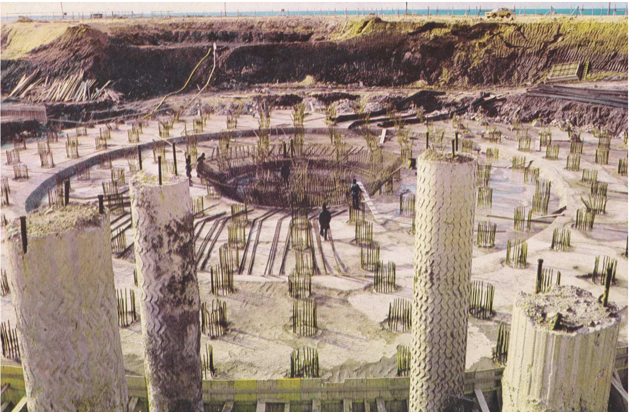
Foto 3 - Pali di fondazione per la Centrale termoelettrica di Civitavecchia (RM)
